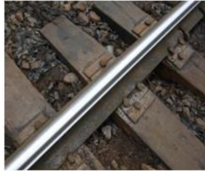
Износ внутренней границы рельс
