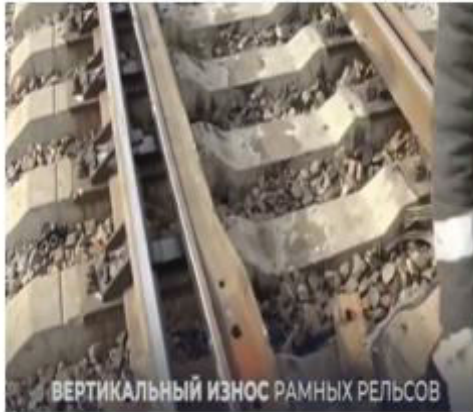
Вертикальный износ рамных рельс
